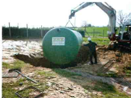
Remplacement de la fosse toutes eaux de la station d'épuration réalisé par l'entreprise GUERET TP de SORBIER
