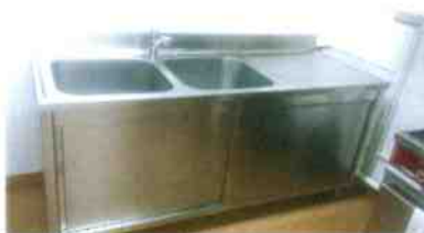
Installation d'une plonge inox à la cuisine de la salle polyvalente
